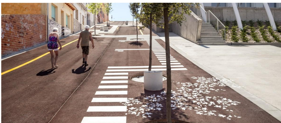
Plataforma única con bandas delimitadas mediante intervención de bajo coste con pintura en Malgrat de Mar. Fuente: http://territori24.com/?projects=segre-street
