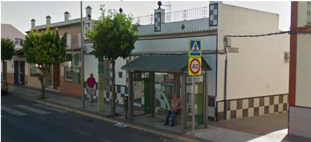
Ilustración 25. Detalle de la marquesina sita en Av. Constitución, 44.
