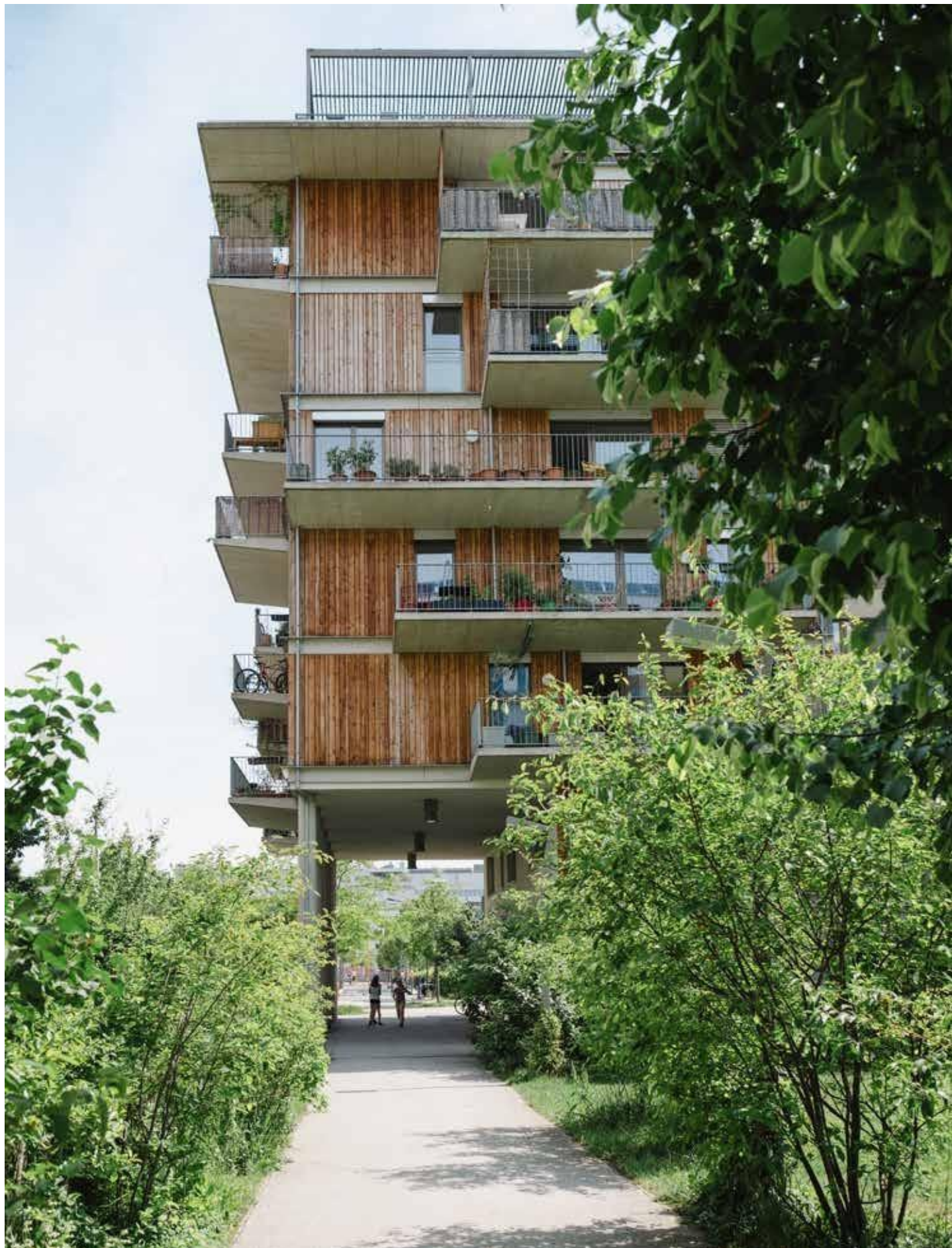
Proyecto de vivienda colaborativa Wohnprojekt Wien, Viena, Austria. Arquitectura: einszueins architektur. Fotografía: Luiza Puiu.
